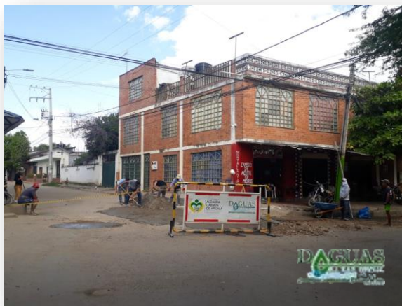
Carrera 9 con Calle 4 esquina del Barrio Centro
