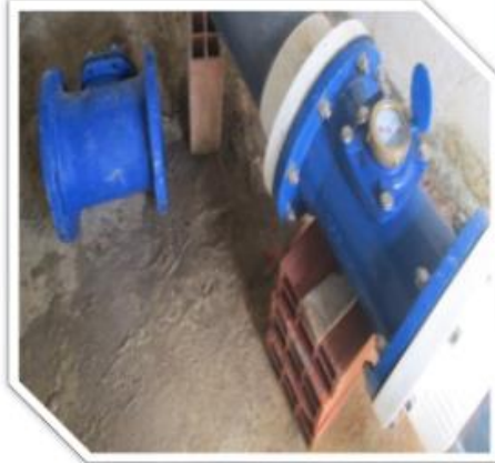
Instalación de Macro-Medidores de 8”, 6” y 4”
