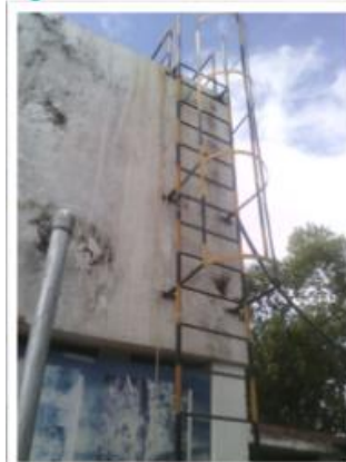
Escalera Metálica en Mal Estado y de Acceso Peligroso
