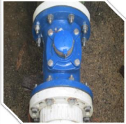
Instalación de Macro-Medidores de 8”, 6” y 4”
