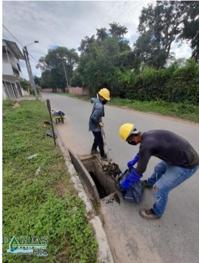
MANTENIMIENTO Y LIMPIEZA DE 160 SUMIDEROS EN EL CASCO URBANO
