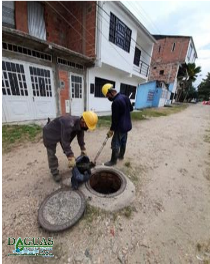
CAMBIO DE 15 ARO TAPAS DE POZOS DEL SISTEMA DE ALCANTARILLADO
